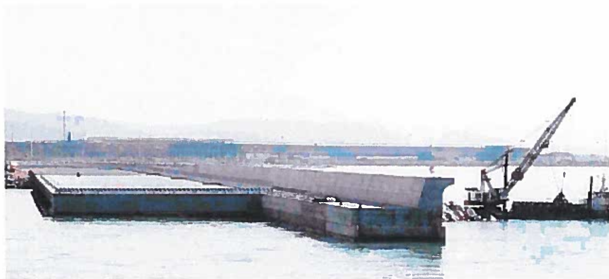
Una fase dei lavori per le nuove banchine sul porto (foto Paolo Barlettani)
